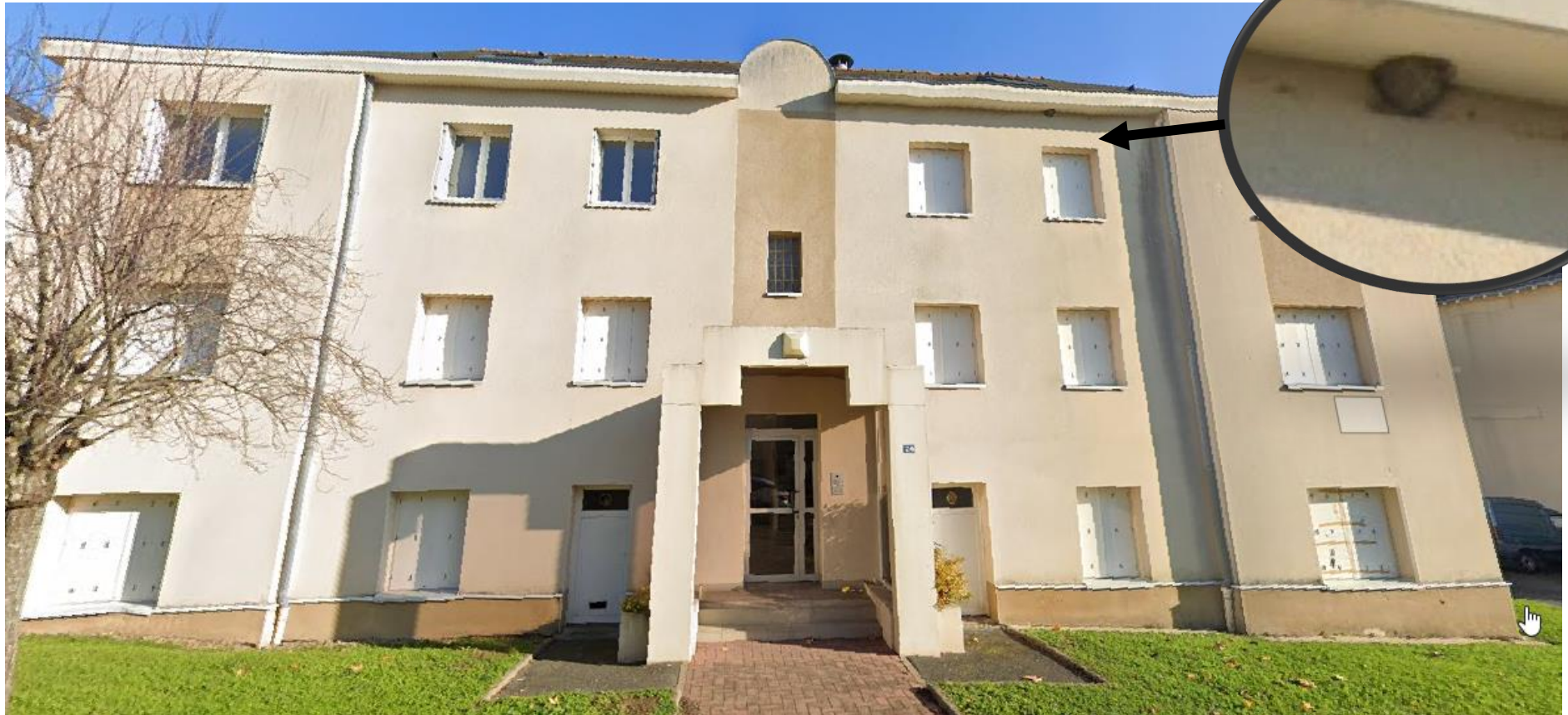
Bâtiment à démolir sis, 24 rue du docteur Baruk à Ste Gemmes sur Loire
